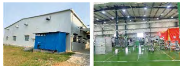
図4 現地生産したPBDやグリルシャッターなどの評価を行う建屋を工場敷地内に設置
