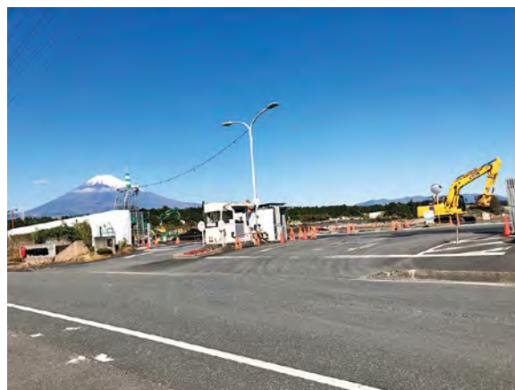
図4 トヨタ「ウーブンシティ」建設現場前より
