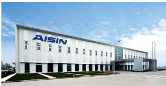
図1 ATC-C正面外観
