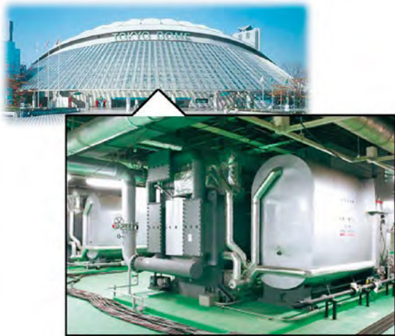
図2 定置型吸収冷凍機の設置例
