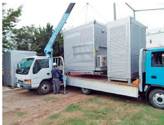
図4 トラックへの積み込み作業
