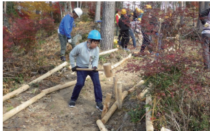
遊歩道の整備
