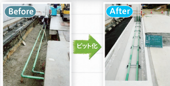
配管の下部・周囲をコンクリートで囲み、ピット化
