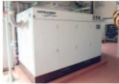
新たに導入したインバーター式コンプレッサー
