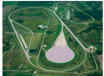
ファアラビル試験場
