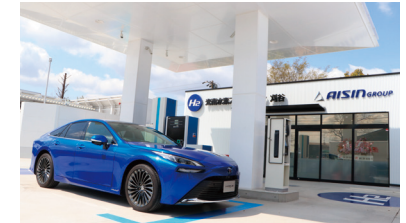
水素ステーション
