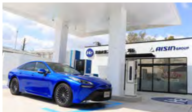
水素ステーション
