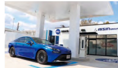
水素ステーション
