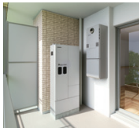
家庭用燃料電池 コージェネレーションシステム (集合住宅の設置例)
