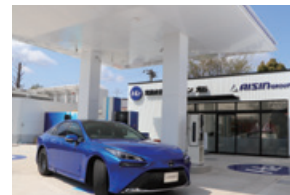
水素ステーション
