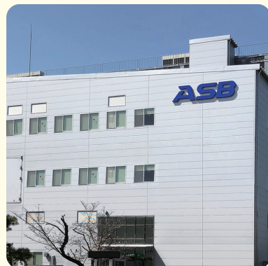
▲本社 伊丹工場
